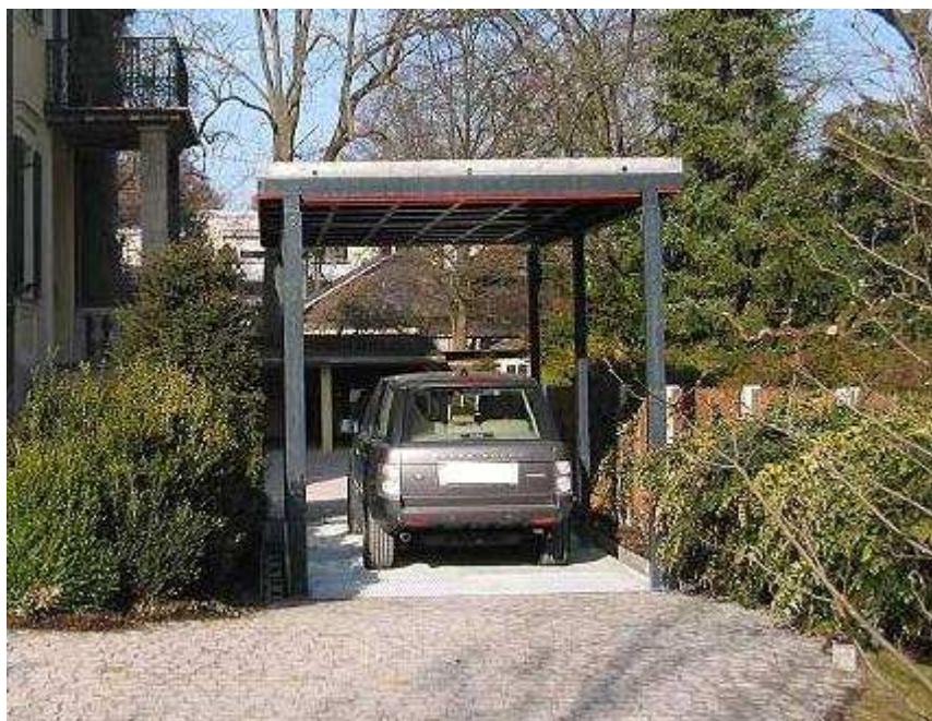
Aufzug in oberer Position - Komfortables Befahren der Plattform von vorne und hinten
