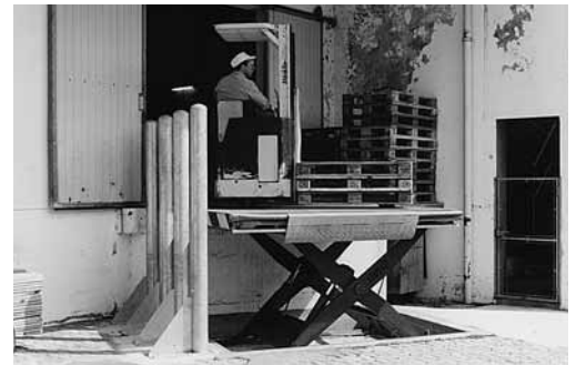
Bild 2: Diese Pfeiler wurden installiert, nachdem ein Staplerfahrer mit seinem Gabelstapler von der Hebebühne gestürzt war.
